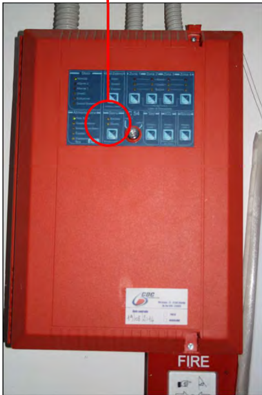
Centrale Rilevazione incendi (Al piano seminterrato)
