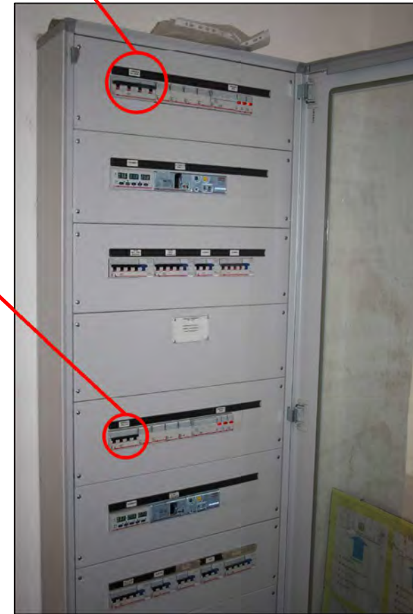
Quadro EI. Aula ex chiesa
